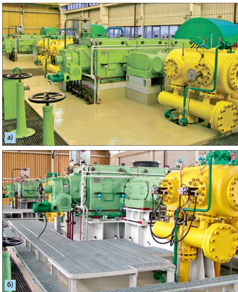
Рис. 6.49. Общий вид поршневых компрессоров 1HB 5K-400/250, эксплуатируемых в газокompрессорных станциях природного газа: а) перед; б) после модернизации конструкции их фундаментов
