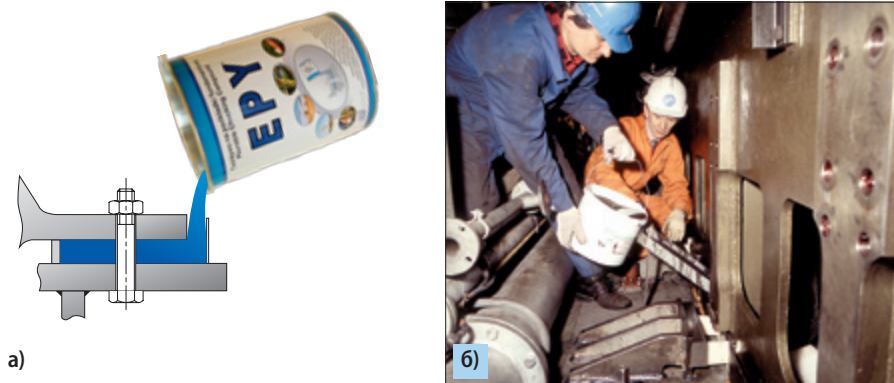
Рис. 5.3. Заливка формы жидкой композицией: а) схема; б) на судне
