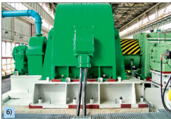
Рис. 6.48. Элементы компрессорного состава, установленного на подкладках, отлитых из пластмассы: а) коробка водилка; б) двигатель
