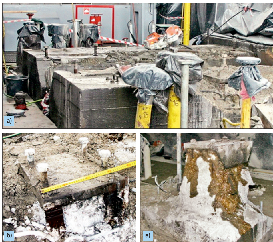
Рис. 6.43. Пример полного разрушения верхней части фундамента поршневого компрессора с видимым пакетом ослабленных стальных плит вблизи фундаментных болтов (а) и глубокими разрывами бетона, а также вытекание масла (б, в)
