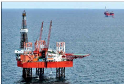
Рис. 6.32. Буровые платформы „Petrobaltic” и „Baltic Beta”; на первой из них якорная лебёдка (1984) и генератор (1994) были установлены на подкладках из пластмассы; работы были выполнены на судоремонтном заводе “Radunia”; на второй платформе подобным образом были установлены три генератора типа WAB 1240 D6, а также три подшипника; эти работы были выполнены в морских условиях (2004—2005)
