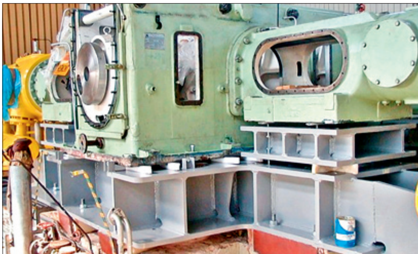
Рис. 6.47. Размещение составных элементов компрессора на фундаментной раме с помощью установочных болтов и клиньев
