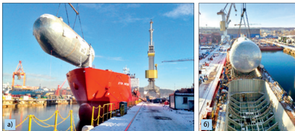
Рис. 6.30. Цистерна массой 500 тонн (а) в процессе монтажа внутрь корпуса судна „Syn Antares” (б)
