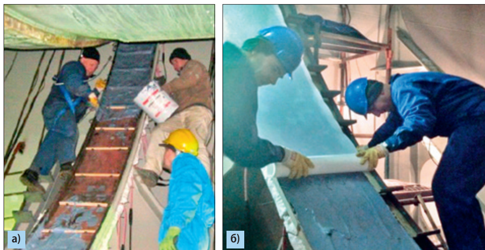
Рис. 6.31. Фрагменты монтажных работ, показывающих процесс накладки пластмассы на опорную поверхность фундамента цистерны (а) и прикрытия её тефлоновой фольгой (б)
