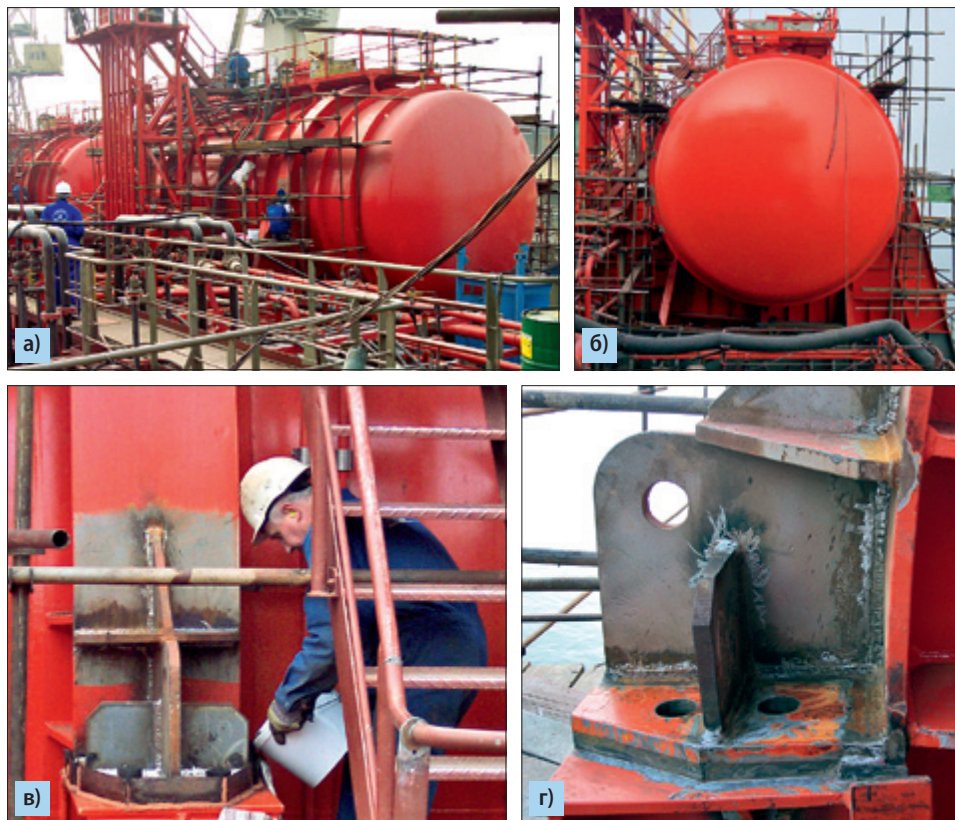
Рис. 6.25. Монтаж цистерны на палубе судна: а) и б) общий вид цистерны во время монтажа; в) заливка заливного пространства пластмассой; г) лапа цистерны на подкладке из пластмассы, отлитой на верхней плоской поверхности фундамента цистерны
