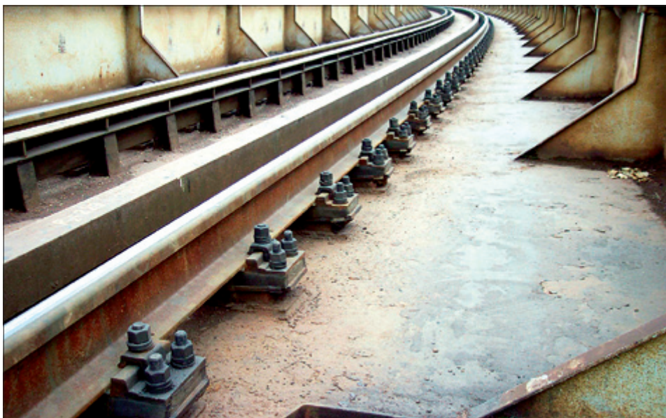
Рис. 6.70. Пример применения пластмассы EPY для уложения железнодорожных рельсов на стальной эстакаде (Щецин)
