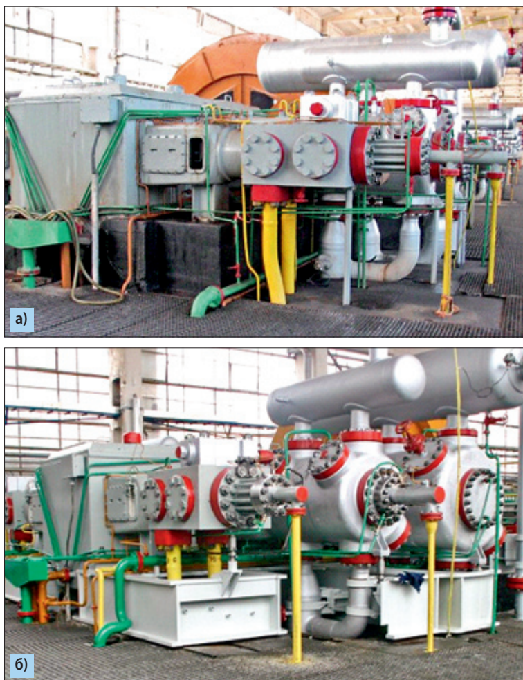
Рис. 6.50. Общий вид поршневого компрессора синтез-газа 6HGP/4: а) до модернизации; б) после модернизации фундамента
