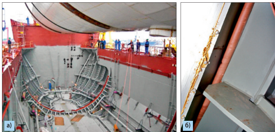
Рис. 6.28. Устанавливание цистерны на фундаменты, покрытые пластмассой (а) и фрагмент фундамента с заметной пластмассой, выдавленной из фундамента во время монтажа цистерны (б)
