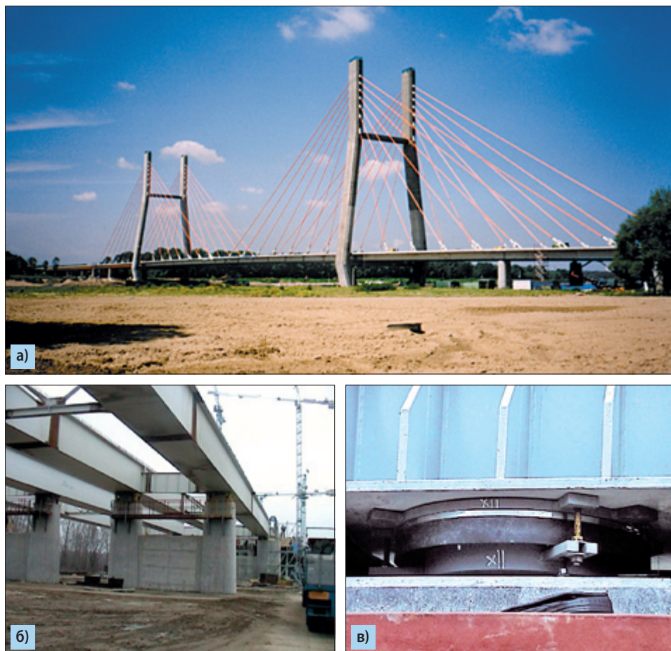
Рис. 6.68. Мост „Siekierkowski” в Варшаве во время постройки (2001 год): а) общий вид моста; б) вид пролета; в) вид подшипника, установленного на пластмассе EPY по схеме, показанной на рис. 6.66г
