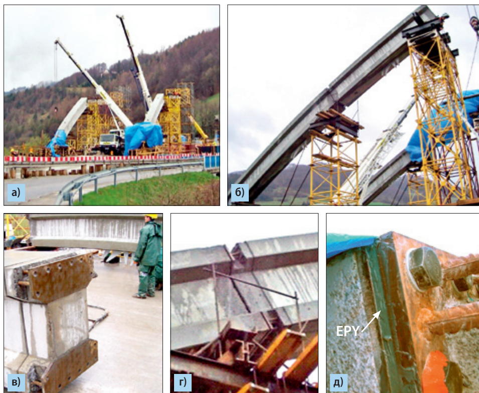
Рис. 6.71. Применение пластмассы ЕРУ для монтажа сегментов железобетонных арочных балок: а) общий вид моста во время его постройки; б) фрагмент арочной балки; в) вид поверхности стыка сегмента арочной балки; г) соединение двух фрагментов арочной балки с видимой щелью для заполнения её пластмассой; д) фрагмент многоболтового скрепления сегментов с видимой щелью, заполненной пластмассой ЕРУ
